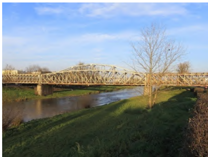
Rys. 9. Most kolejowy na Sanie w Przemyśle [11]
